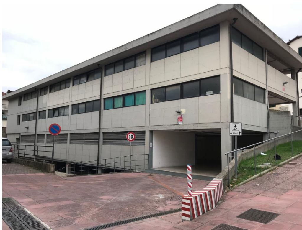
Foto 2 – vista di insieme edificio
