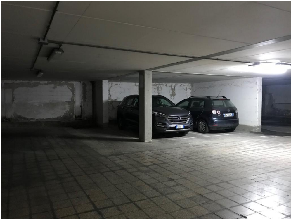
Foto 5 – interno del parcheggio – piano seminterrato
