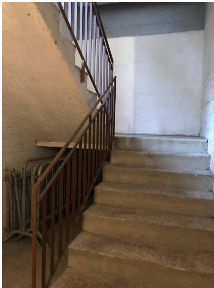
Foto 7 – corpo scala interno
