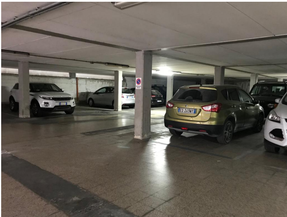
Foto 4 – interno del parcheggio – piano seminterrato
